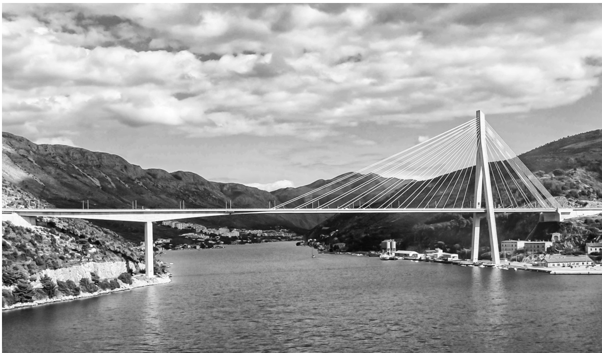
Bild 25 Franjo-Tudjman-Brücke in Dubrovnik (Kroatien)
