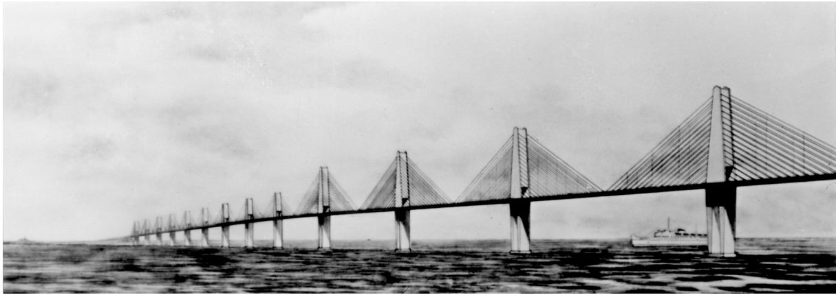
Bild 6 Wettbewerb Brücke Großer Belt: der Vorschlag von Dyckerhoff & Widmann war eine Reihe von Schrägseilbrücken [17] Foto: Werkfoto D&W
