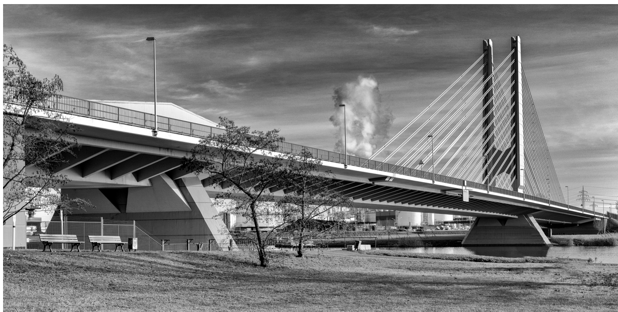
Bild 17 2. Mainbrücke der Hoechst AG
