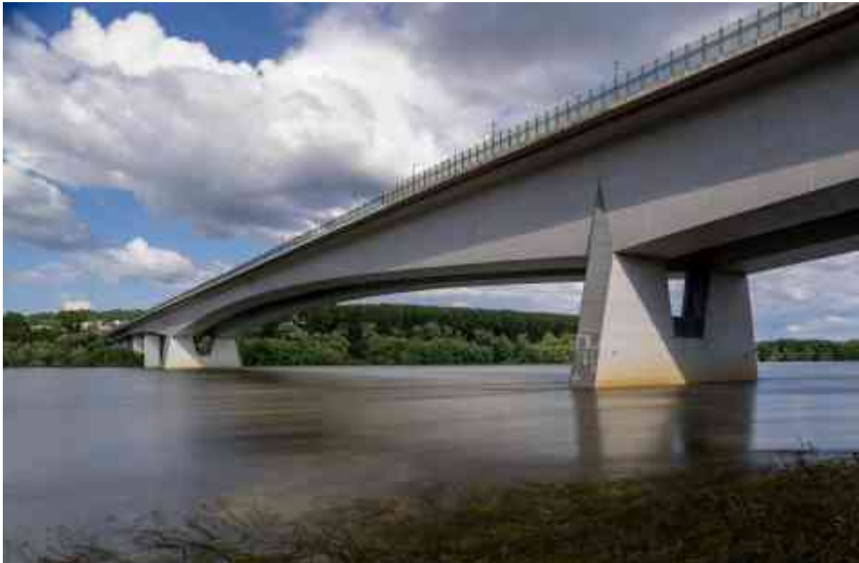
Bild 12 Rheinbrücke Bendorf: Der elegante Entwurf von Finsterwalder, Schambeck und Lohmer war nicht nur die preisgünstigste Lösung, sondern hielt auch den Weltrekord als weitest gespannte Betonbalkenbrücke Foto: C. Diceli (2021)
