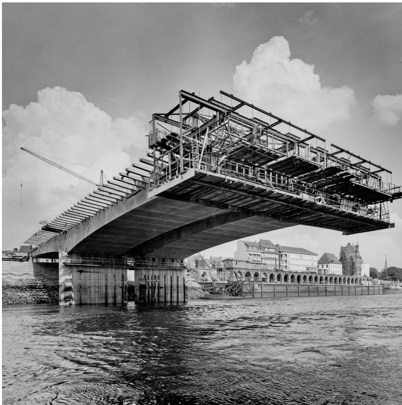
Bild 9 Große Weserbrücke Bremen, erster Freivorbau in Norddeutschland Foto: PASch, Werkfoto D&W
