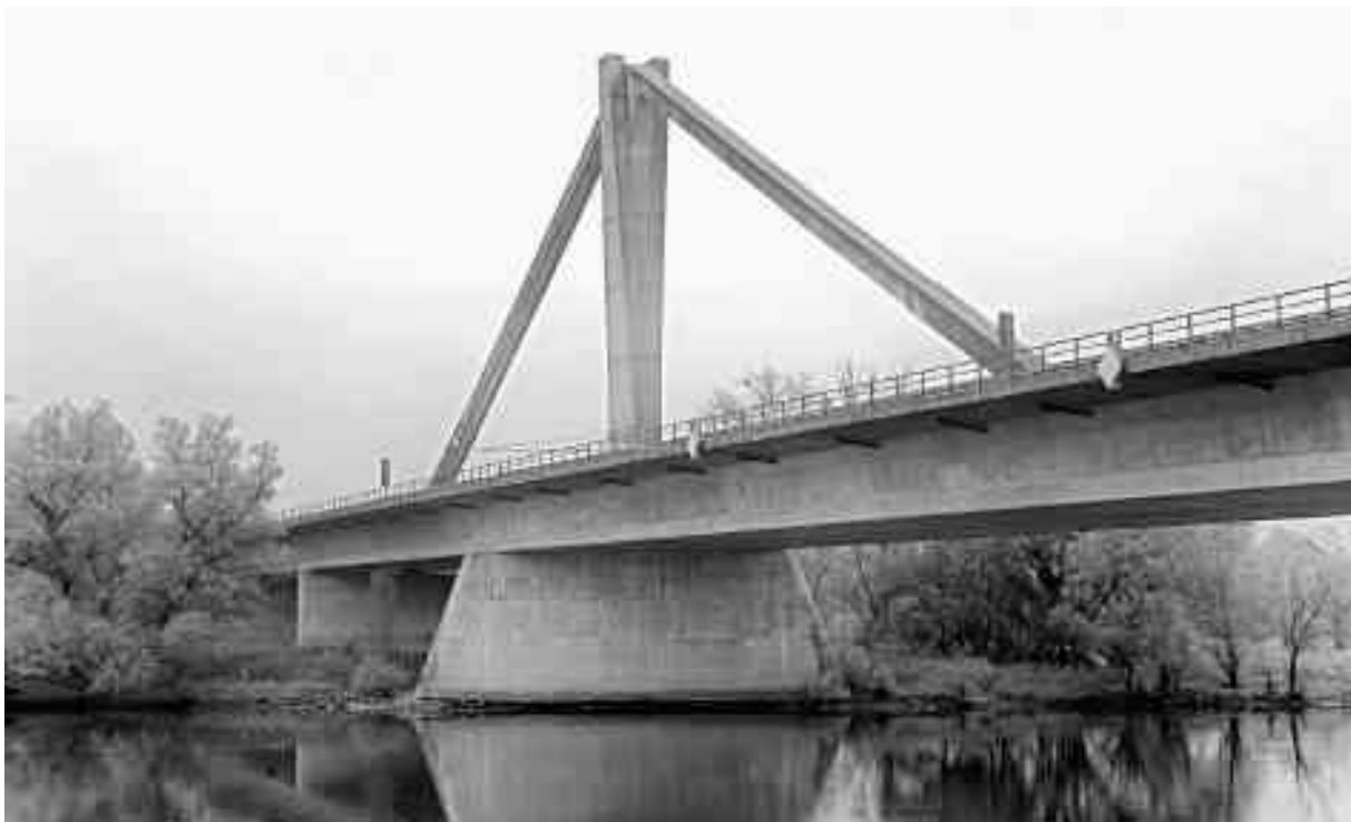
Bild 23 Donaubrücke Metten mit Zügelgurt
