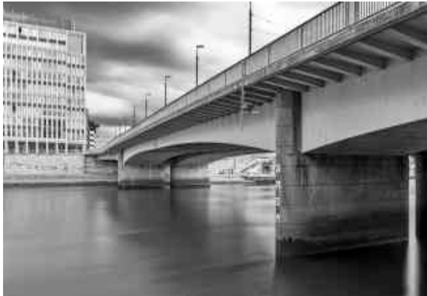
Bild 10 Große Weserbrücke Bremen, Ansicht Foto: C. Dicleli (2021)
